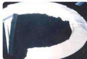
Рисунок 4. Керамическое одеяло НЕ должно нависать над внешним краем.
