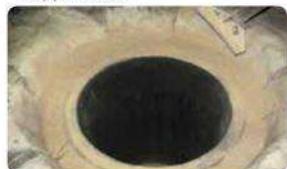
Рисунок 7. Тщательно утрамбуйте подкладочный материал сверху края.
